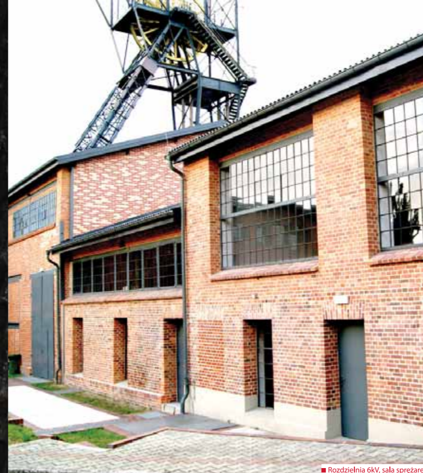
■ Rozdzielnia 6kV, sala sprzężarek
