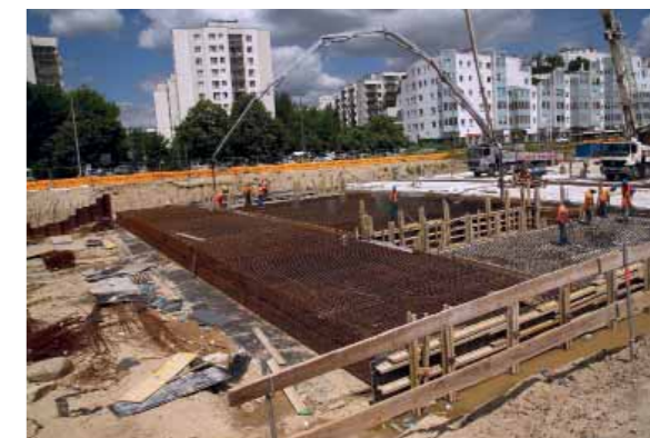
▲ Betonowanie płyty stropowej
