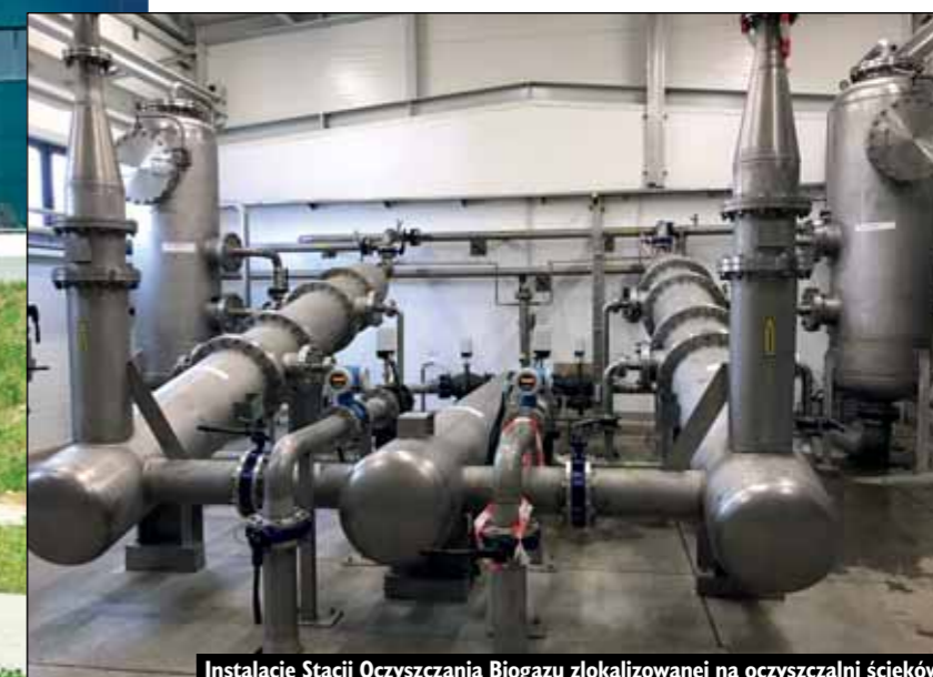
Instalacje Stacji Oczyszczania Biogazu zlokalizowanej na oczyszczalni ścieków
