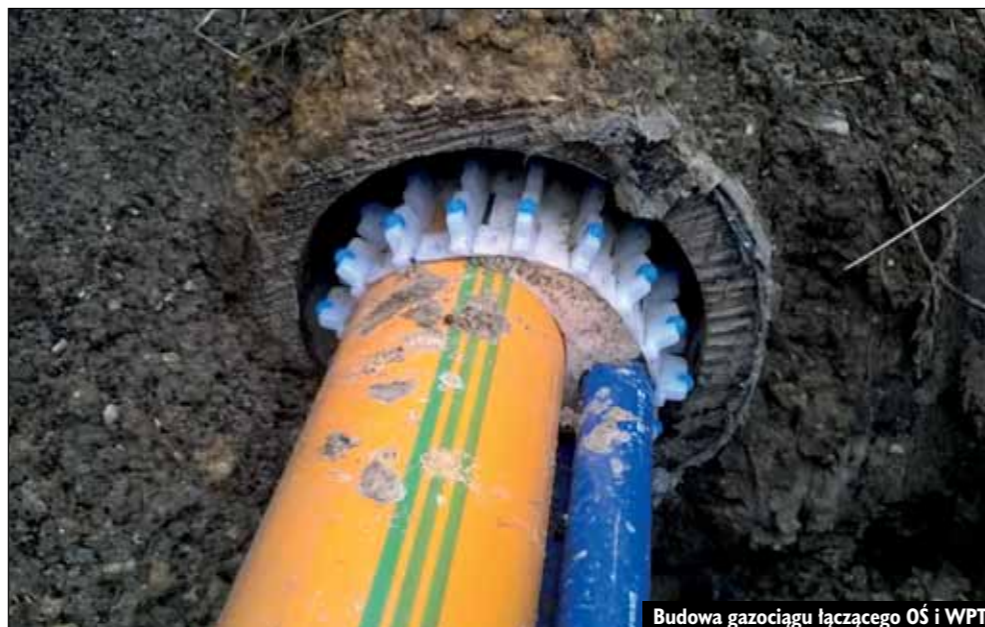
Budowa gazociągu łączącego OŚ i WPT
