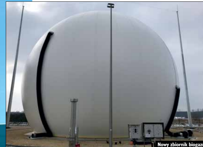
Nowy zbiornik biogazu
