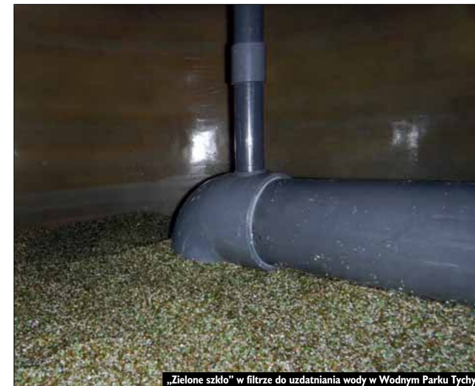
„Zielone szkło” w filtrze do uzdatniania wody w Wodnym Parku Tychy
