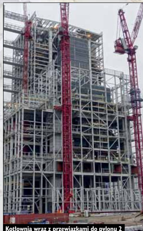
Kotłownia wraz z przewiązkami do pylonu 2
