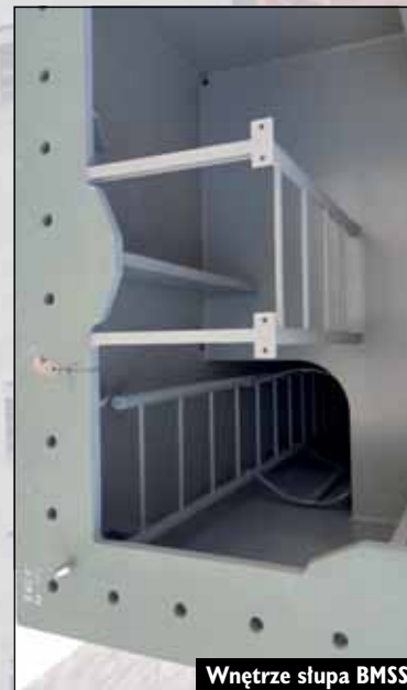
Wnętrze słupa BMSS
