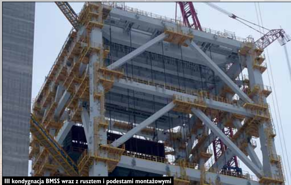
III kondygnacja BMSS wraz z rusztem i podestami montażowymi
