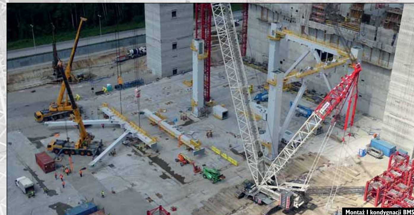
Montaż i kondygnacji BMSS
