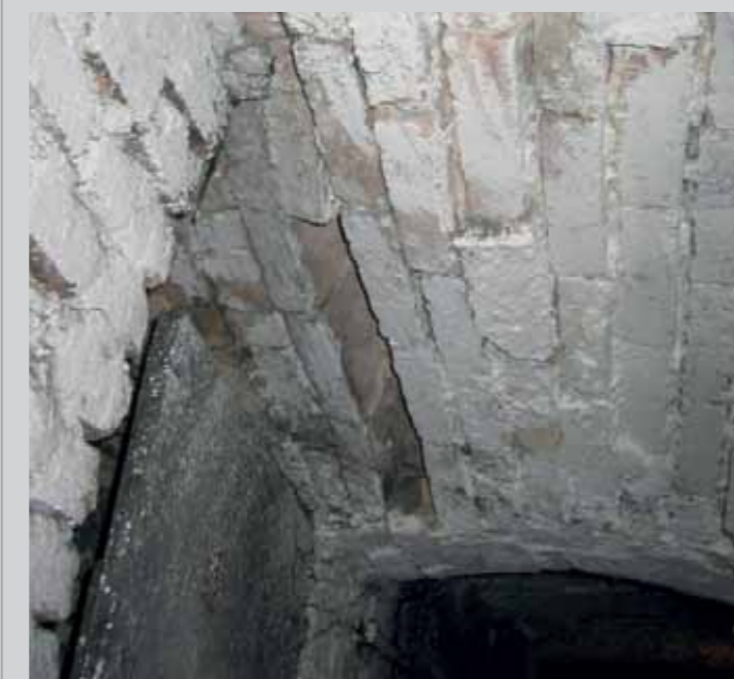
Przykłady silnych spękań powstałych wskutek rozpełzań podłoża. (fot. I.Bryt-Nitarska)
