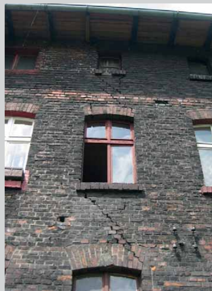
Przykłady silnych spękań powstałych wskutek rozpełzań podłoża. (fot. I.Bryt-Nitarska)
