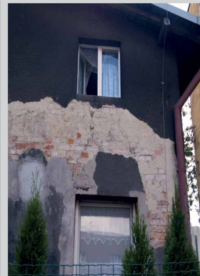
Przykłady uszkodzeń powstałych wskutek wielokrotnego oddziaływania wstrząsów górniczych. (fot. I. Bryt-Nitarska)
