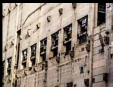
zdjęcie pod tytułem „Dawna Elektrownia w Hirschfelde w Niem- czech”, autor: Edyta Werkowska
