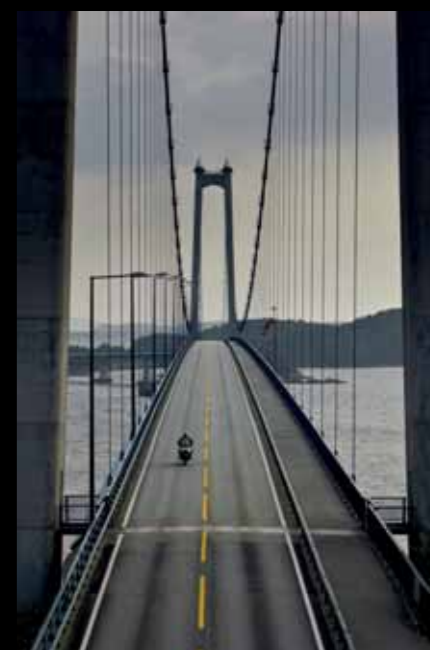
miejsce I zdjęcie pod tytułem „Most Stordabrua na wyspę Stord, Norwegia”, autor: Andrzej Bączkowiec
