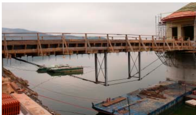
Kładka przygotowana do betonowania
