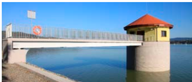
Ujęcia wody po ukończeniu budowy
