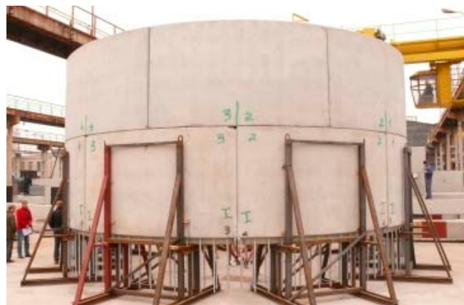
Prefabrykaty – pomiary w wytwórni
