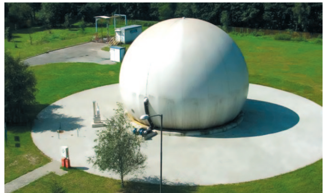
Zbiornik biogazu na Oczyszczalni ścieków „Śródmieście”
