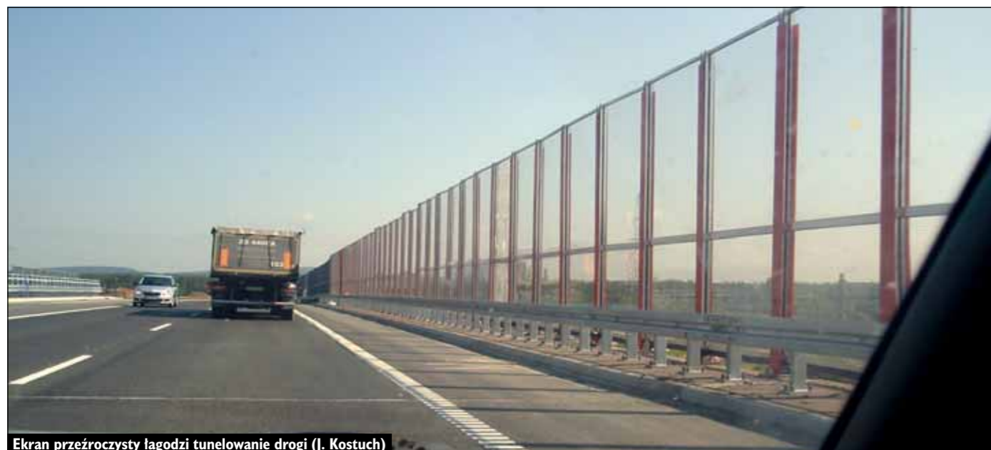
Ekran przezroczysty łagodzi tunelowanie drogi (J. Kostuch)
