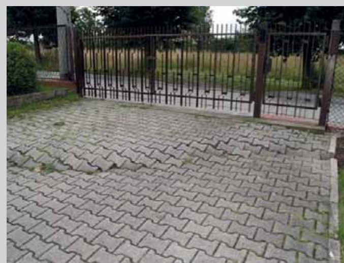
Przykłady deformacji liniowych, progów ujawnionych w terenie. (fot. I. Bryt-Nitarska)
