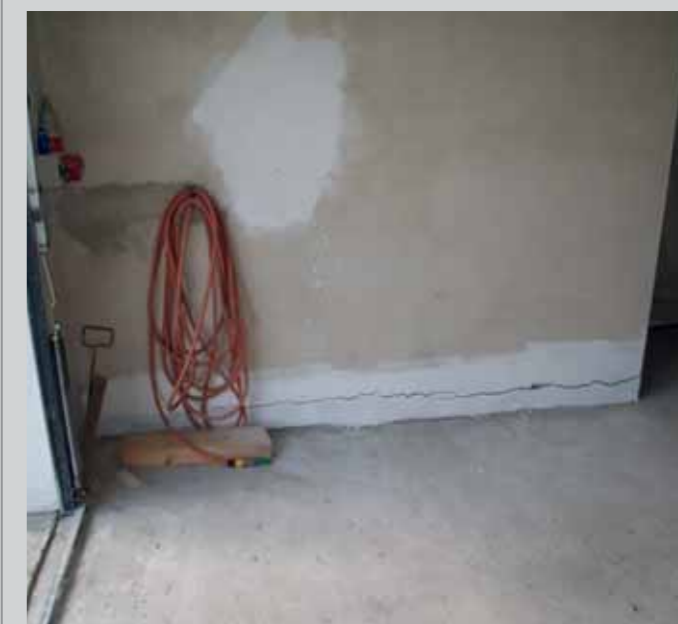
Przykłady uszkodzeń elementów konstrukcji wskutek aktywacji progów terenowych pod budynkiem. (fot. I. Bryt-Nitarska)
