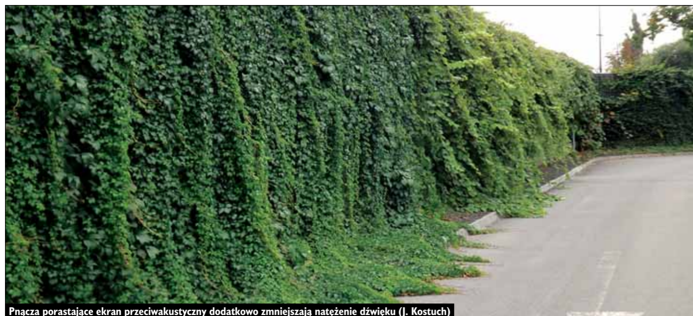
Pnącza porastające ekran przeciwakustyczny dodatkowo zmniejszają natężenie dźwięku (J. Kostuch)
