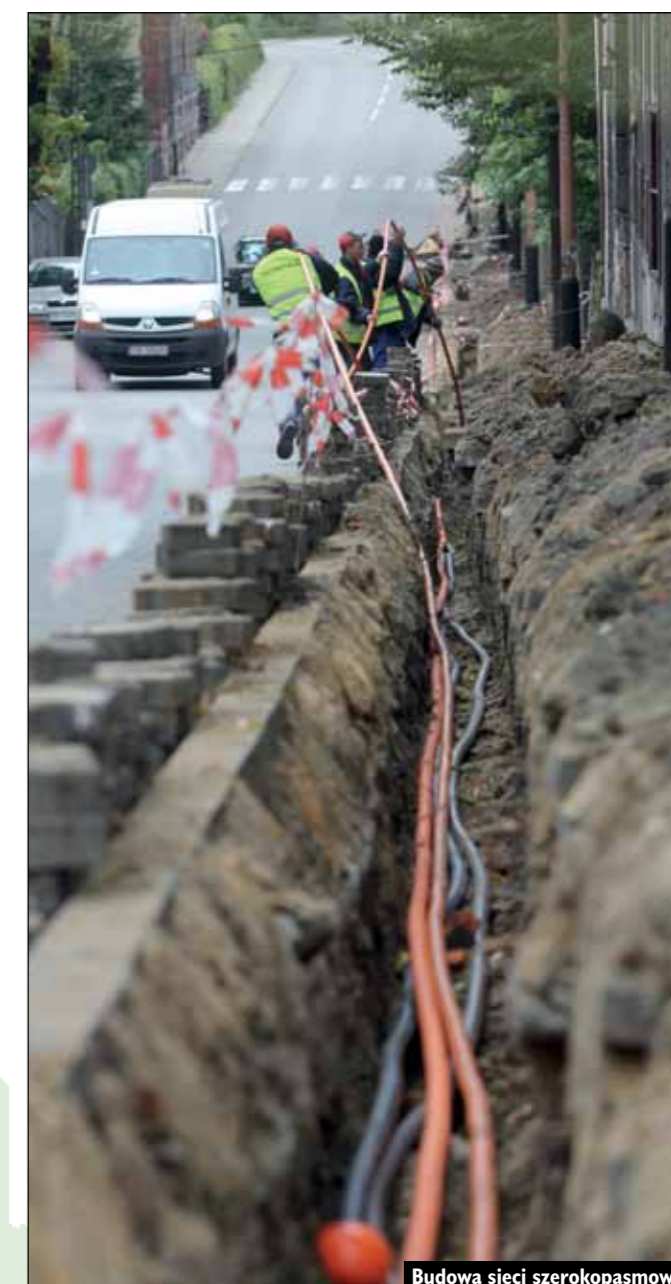
Budowa sieci szerokopasmowej
