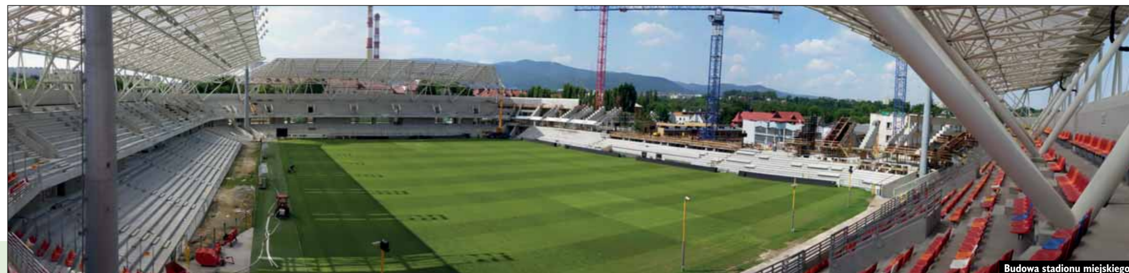
Budowa stadionu miejskiego
