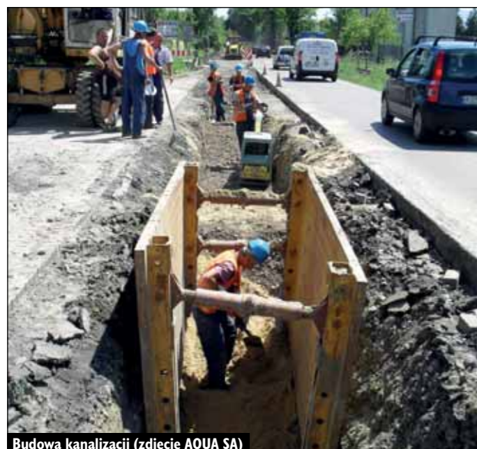
Budowa kanalizacji (zdjęcie AQUA SA)
