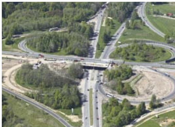
Widok z lotu ptaka na przebudowę węzła "Komorowice" wraz z wiaduktem WD1, etap II przebudowy wiaduktu - jezdnia południowa
