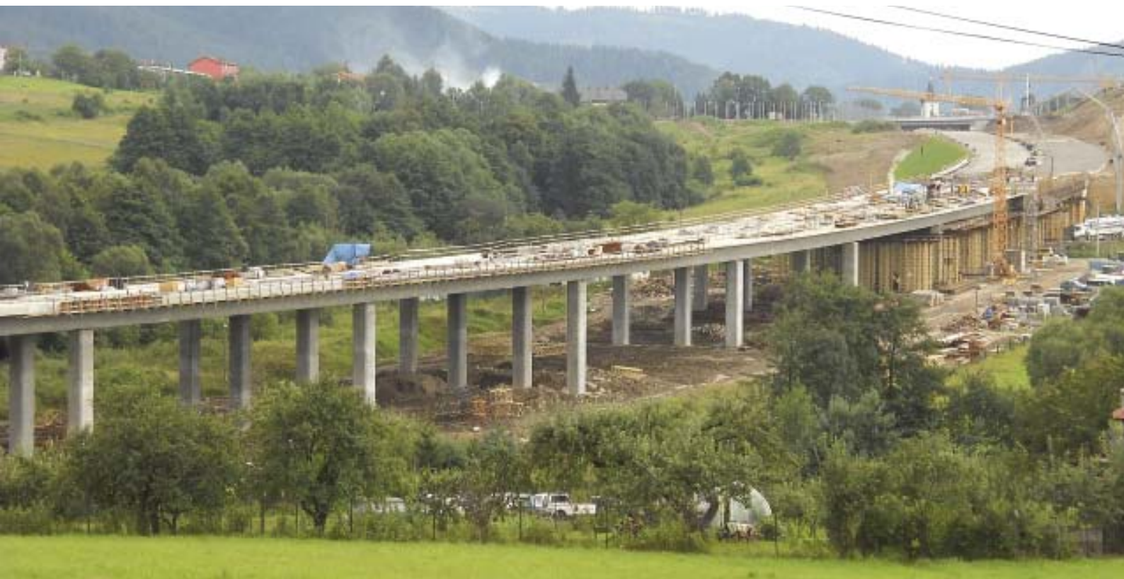
Wiadukt WS5 w km 5+716 (odc.II/2) budowany metodą nasuwania podłużnego
