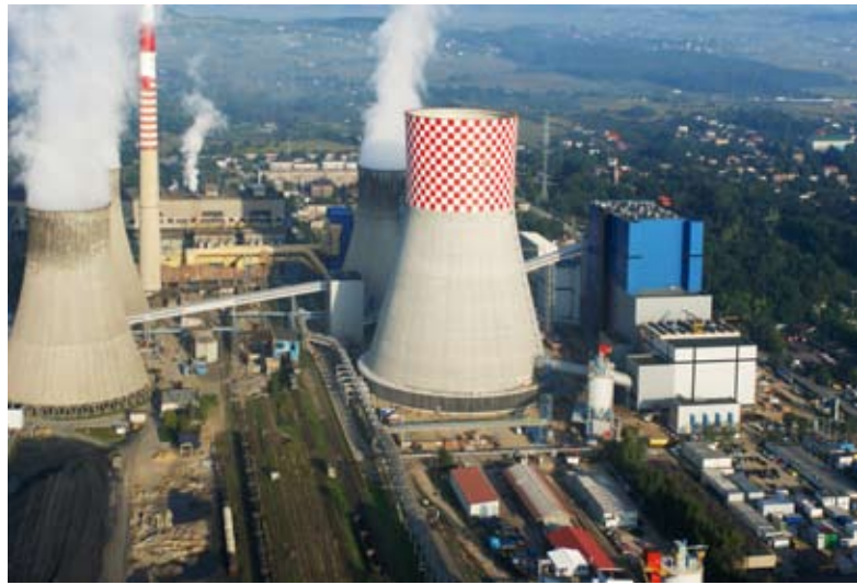
Chłodnia kominowa w Elektrowni Łagisza
