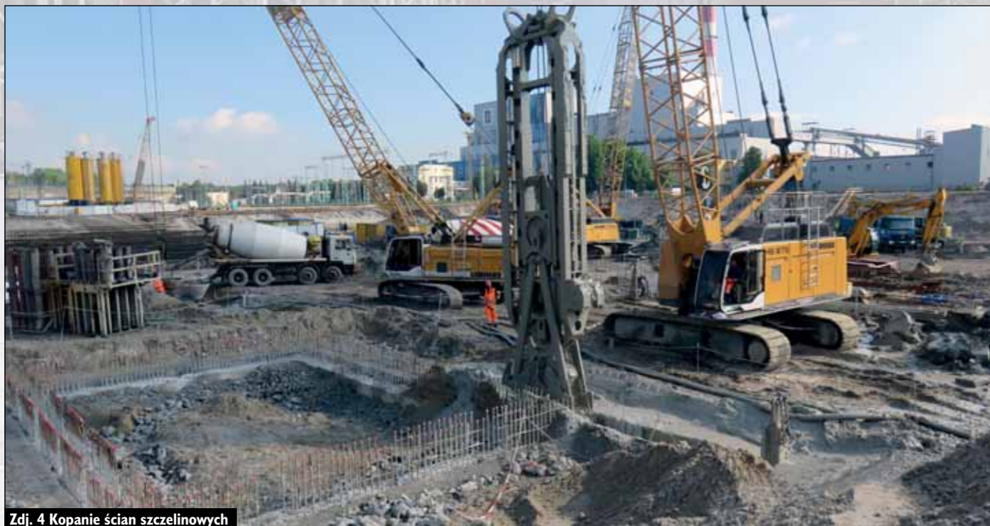
Zdj. 4 Kopanie ścian szczelinowych
