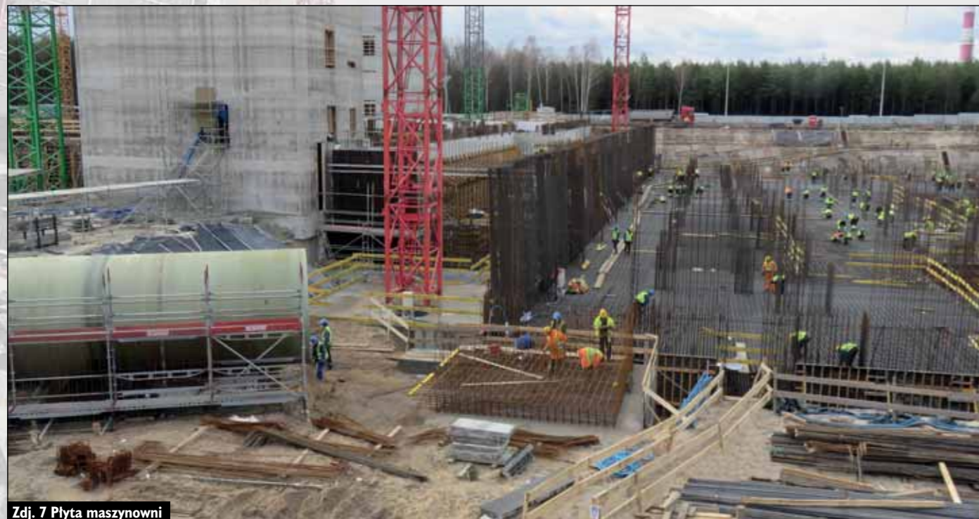
Zdj. 7 Płyta maszynowni
