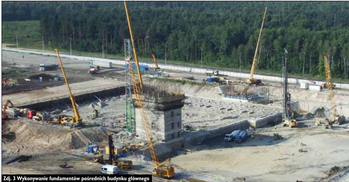
Zdj. 3 Wykonywanie fundamentów pośrednich budynku głównego
