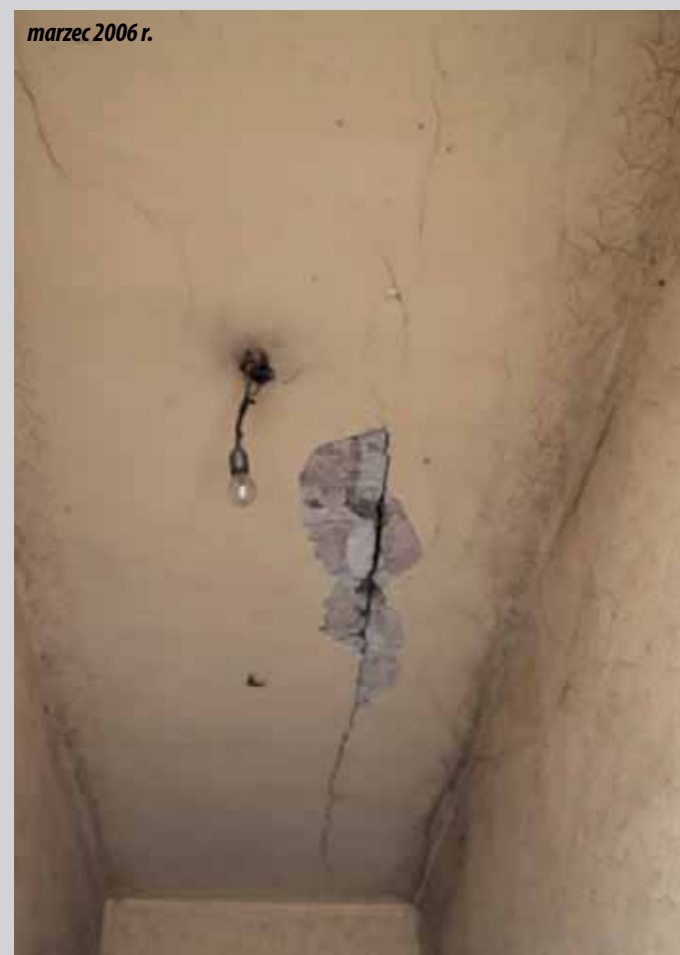
Przykład zmiany stanu uszkodzenia stropu DMS w klatce schodowej budynku podlegającym oddziaływaniom górniczym. (fot. I. Bryt-Nitarska)
