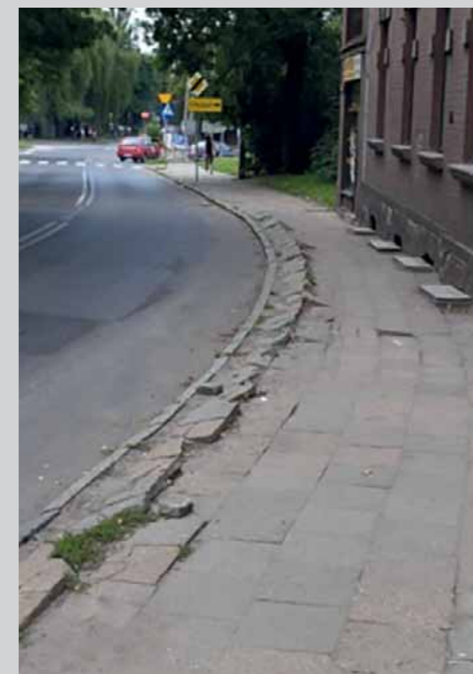
Przykłady powstania deformacje powierzchni w strefach ujawniania się silnych spełzań gruntu. (fot. I. Bryt-Nitarska)
