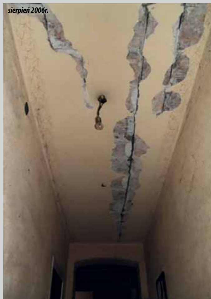
Przykład zmiany stanu uszkodzenia stropu DMS w klatce schodowej budynku podlegającym oddziaływaniom górniczym. (fot. I. Bryt-Nitarska)
