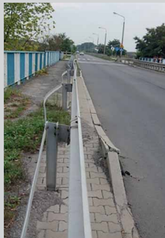
Przykłady powstania deformacje powierzchni w strefach ujawniania się silnych spełzań gruntu. (fot. I. Bryt-Nitarska)
