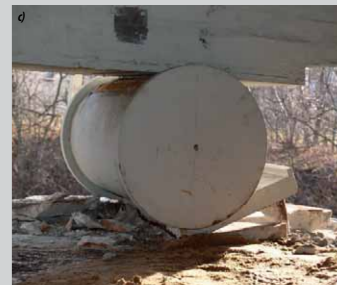
Skutki zsunięcia się podpór mostowych w warunkach ujawniania się silnych spełzań podłoża (fot. I. Bryt-Nitarska):
