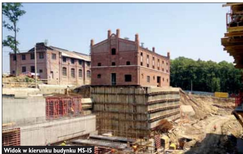
Widok w kierunku budynku MS-15
