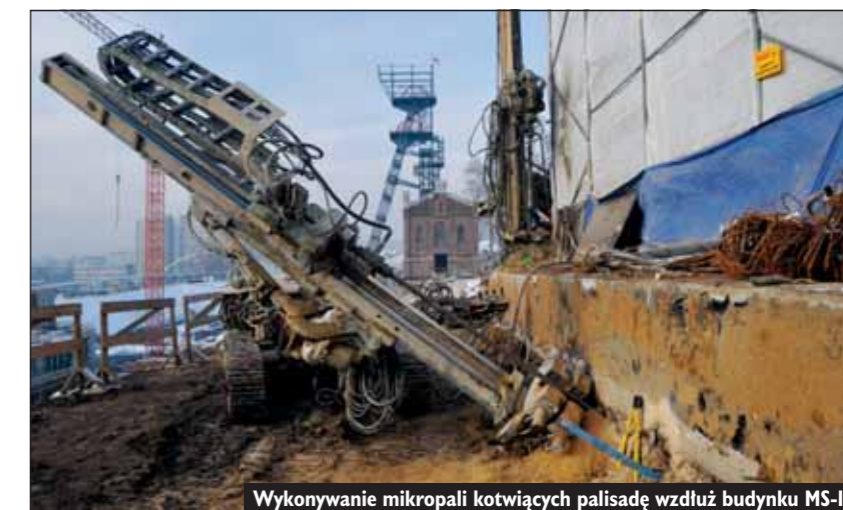
Wykonywanie mikropali kotwiących palisadę wzdłuż budynku MS-15
