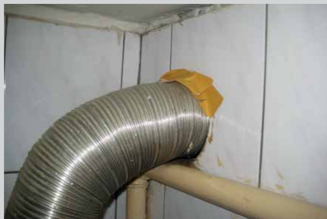
Rys 3. Brak stalowej rozety na wlocie. Włot uszczelniony papierową taśmą. Rura spalinowa styka się z rurą gazową.
