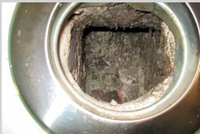
Rys 2. Włot spalinowy po zamianie kanału wentylacyjnego nie podkuty do pełnego przekroju.
