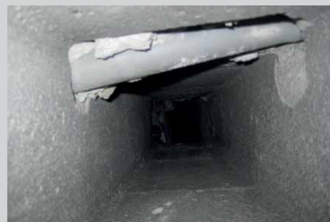
Rys 5. Nieszczelności prefabrykowanego przykanału wentylacyjnego. Przez kanał przeprowadzona jest rura kanalizacji sanitarnej z PCV.
