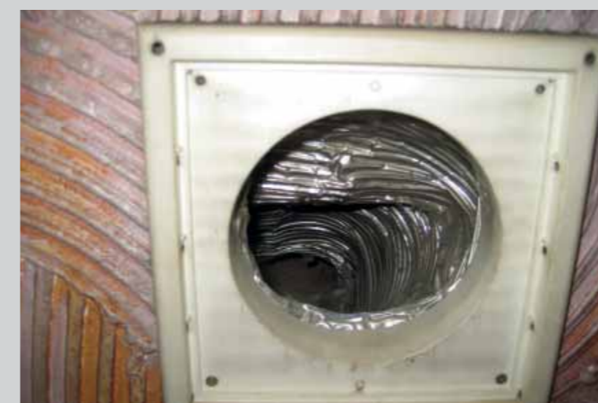
Rys 4. Nieprawidłowe podłączenie - zniekształcony elastyczny przewód aluminiowy.
