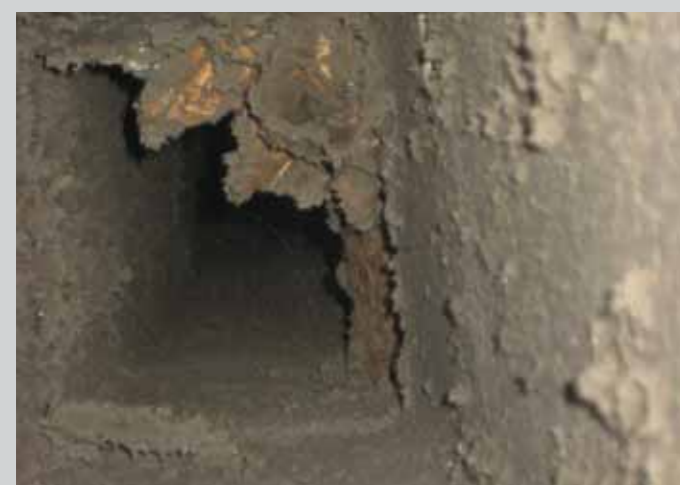
Rys 7. Niedrożność prefabrykowanego przykanalika wentylacyjnego w trakcie montażu obiektu.
