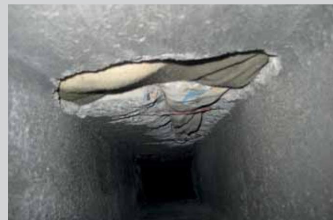
Rys 6. Nieszczelności prefabrykowanego przykanalika wentylacyjnego. Rozkute ścianki kanału zatkałe szmatami.
