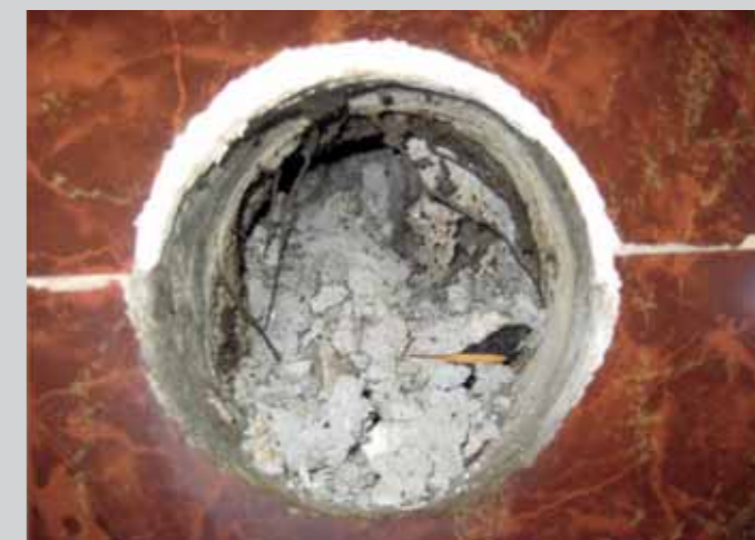
Rys 1. Brak stalowej rozety na wlocie. Wlot zagruzowany w ok. 90%.
