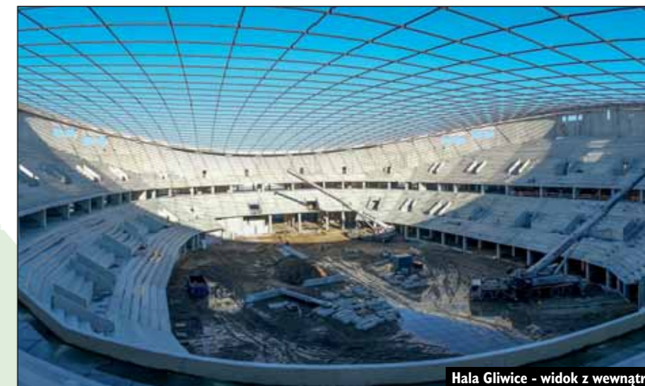
Hala Gliwice - widok z wewnątrz
