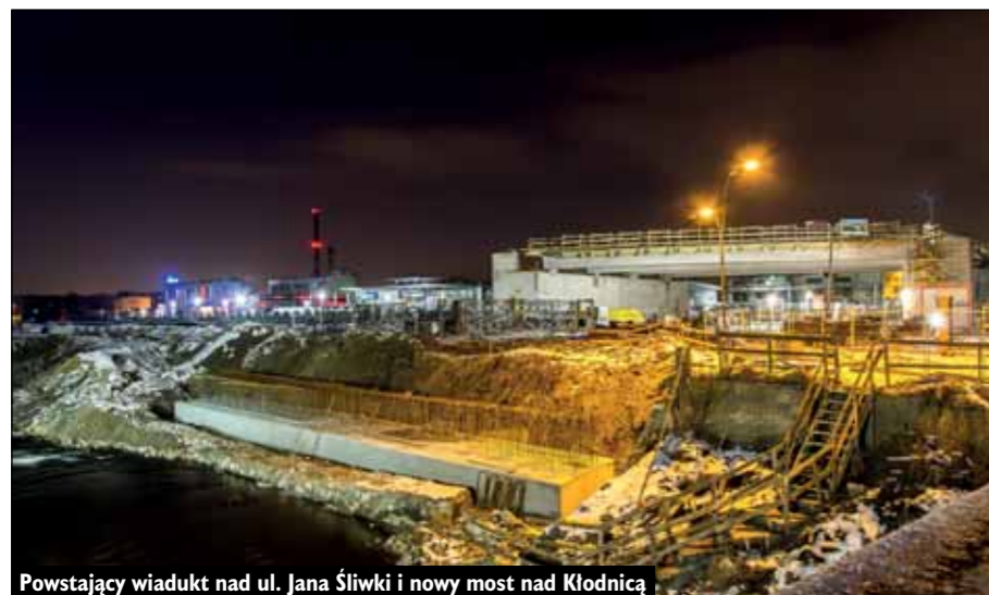
Powstający wiadukt nad ul. Jana Śliwki i nowy most nad Kłodnicą
