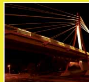
Budowa kładki dla pieszych nad DK 3 w Polkowicach o rozpiętości 6,85+49,23+4x15,8m
