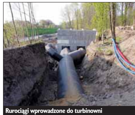
Rurociągi wprowadzone do turbinowni
