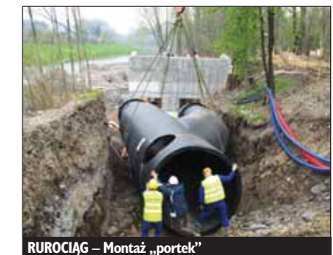
RUROCIĄG – Montaż „portek”
