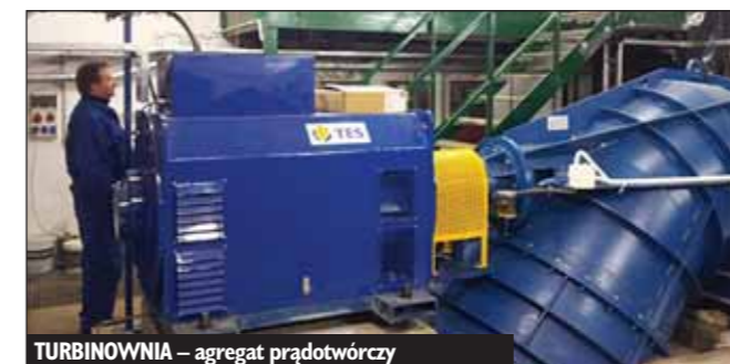
TURBINOWNIA – agregat prądowłoczy
