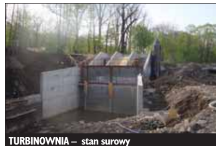
TURBINOWNIA – stan surowy
