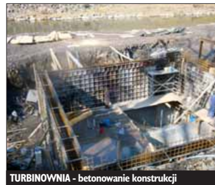
TURBINOWNIA - betonowanie konstrukcji
