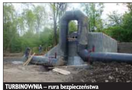
TURBINOWNIA – rura bezpieczeństwa
